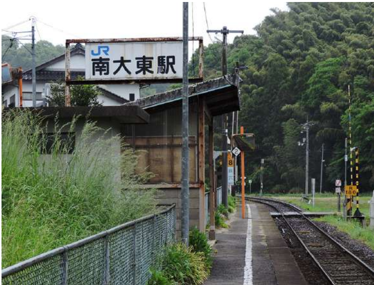
駅舎はなく簡素な待合室だけの“停留駅”だ
