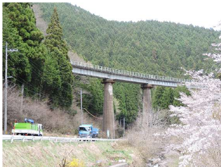
小鳥原第1橋梁を含めて3つの高架鉄橋がある
