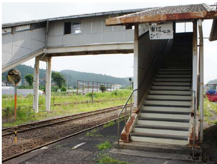
昭和の雰囲気が色濃いホームの跨線橋
