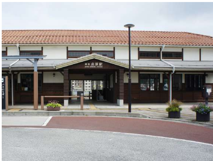
2020年10月にリニューアル工事が完了
