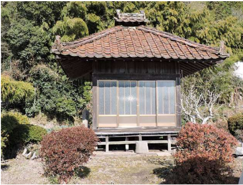
庄原・柳原、西城川脇の「間所薬師堂」
