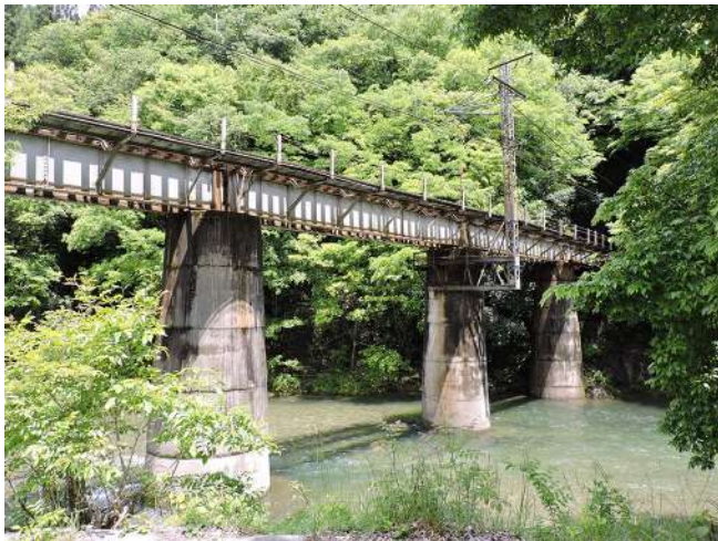
布原駅近くの「第23西川橋梁」
